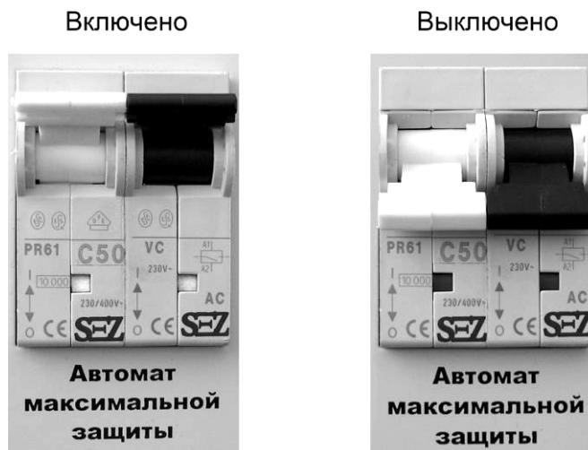
Рис.3. Положения автоматического выключателя.
